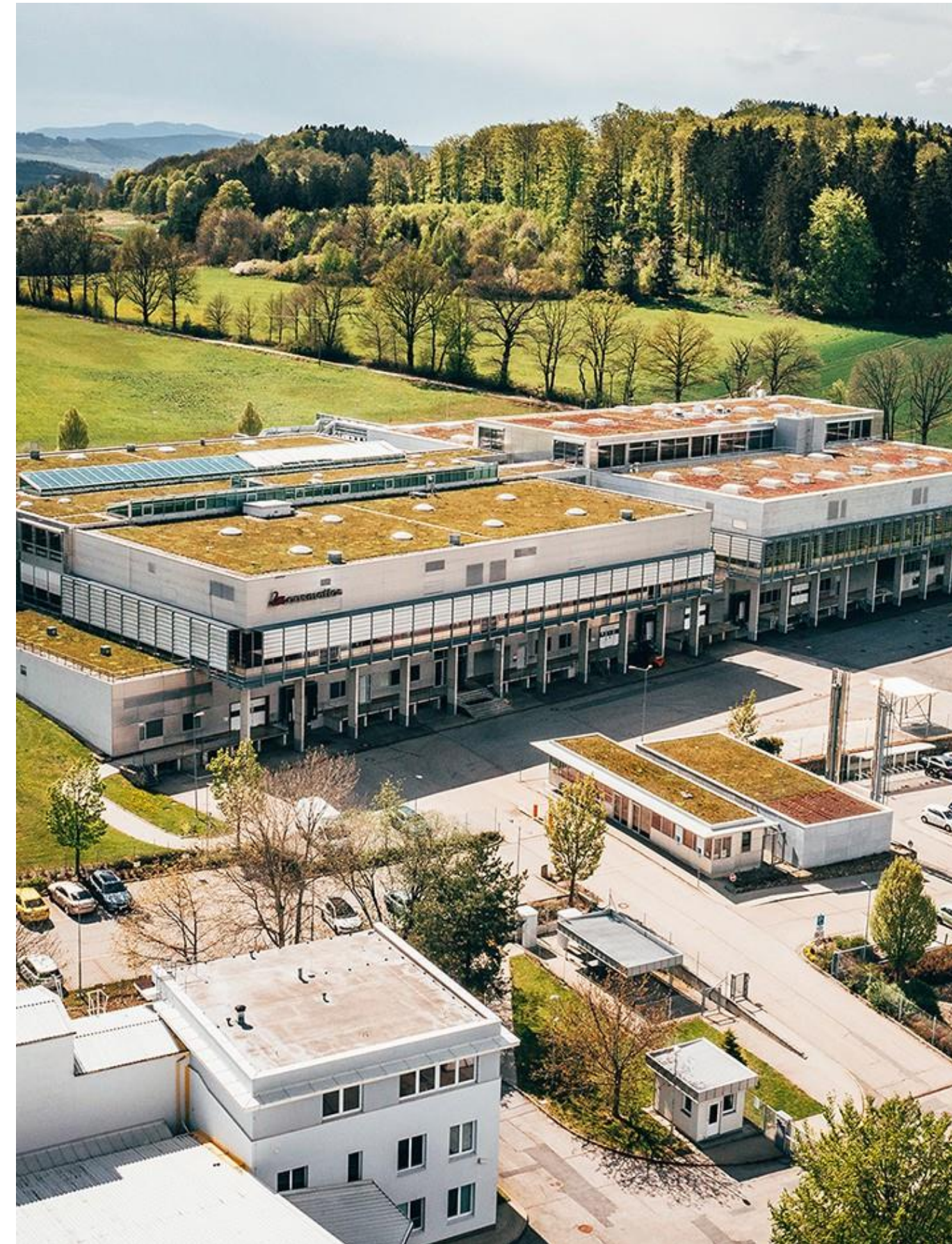
Um die Auswirkungen auf die Umwelt zu minimieren und sich in die Umgebung einzufügen, wurde das Dach des tschechischen Werks begrünt.
